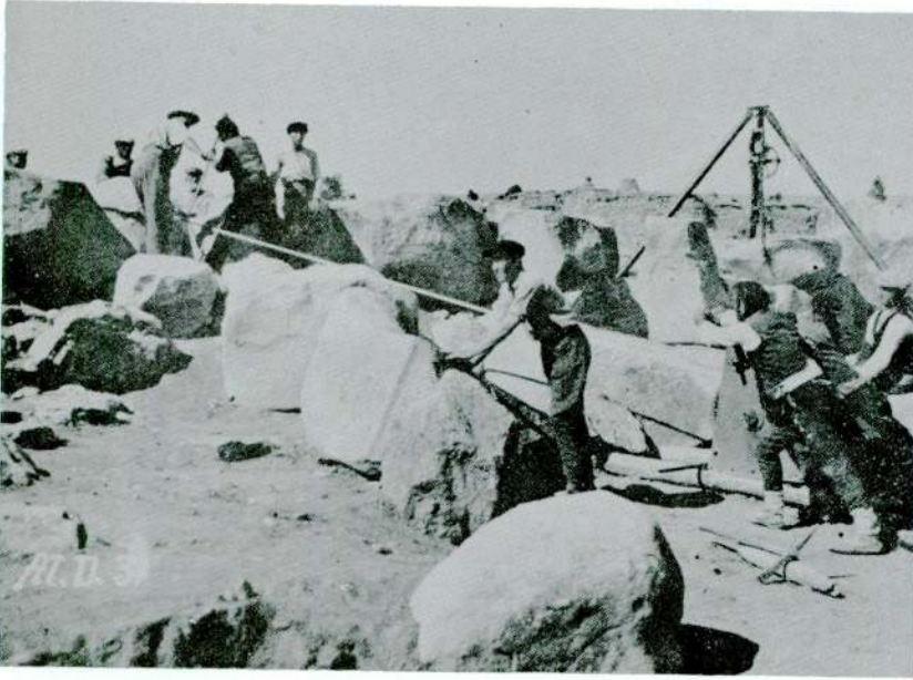
Sfenksli kapının restorasyonu
